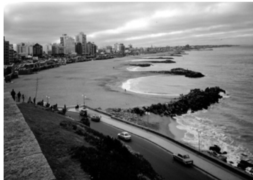
Figura 8: Vista de los espigones en T, estas estructuras provocan importantes volúmenes de acumulación de arena, pero también generan sistemas de baja energía y circulación, entre espigones, que potencia la acción contaminante.
