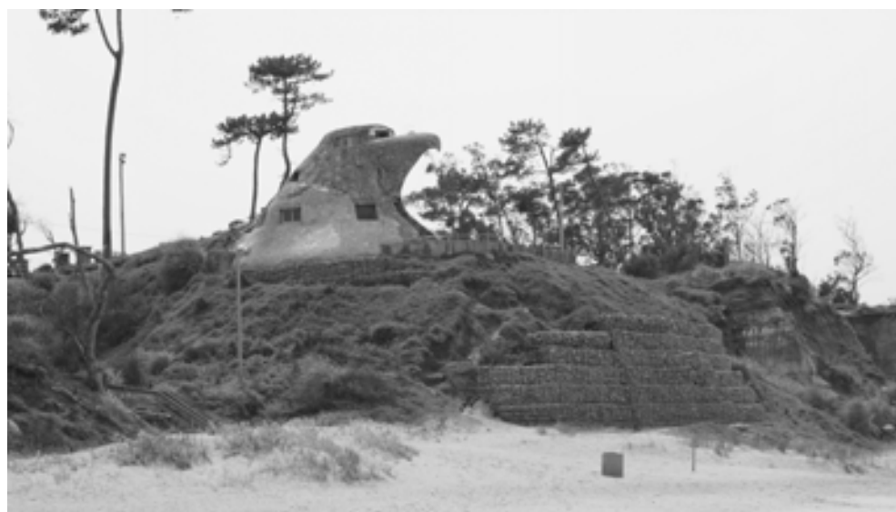
Figura 5: Vista del “Aguila” y de la obra de contención de talud con gaviones. Foto: 2005.
