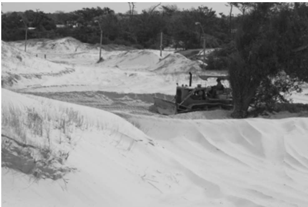
Figura 15: Vista de los trabajos mecanizados de removilización de arena hacia sector de dunas deflacionadas.
