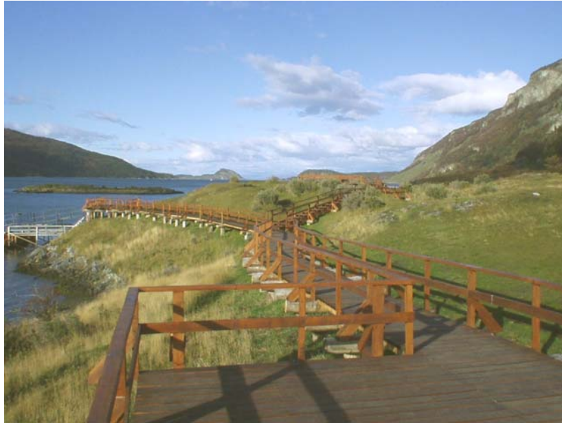
Pasarela entablada en Puerto Arias, Bahía Lapataia (Foto D. Ramos)
