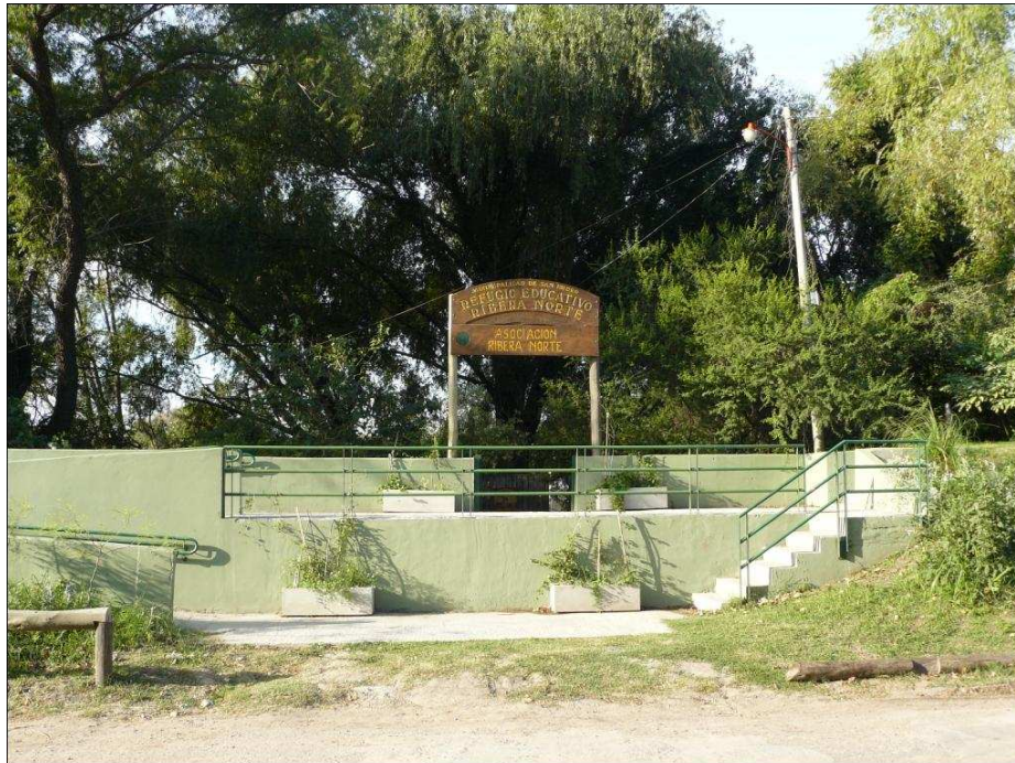
Foto 26. Rampa de acceso y escalera. Foto: Gastón Rodríguez Tourón.
