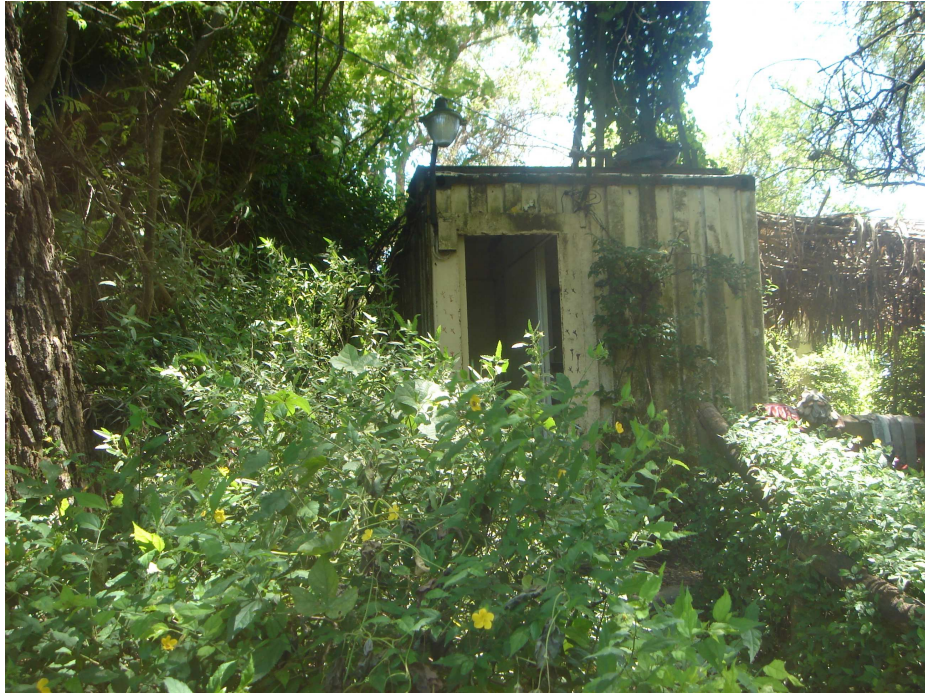
Foto 1. Container con espacio multiuso y baños. Foto: Gastón Rodríguez Tourón.
