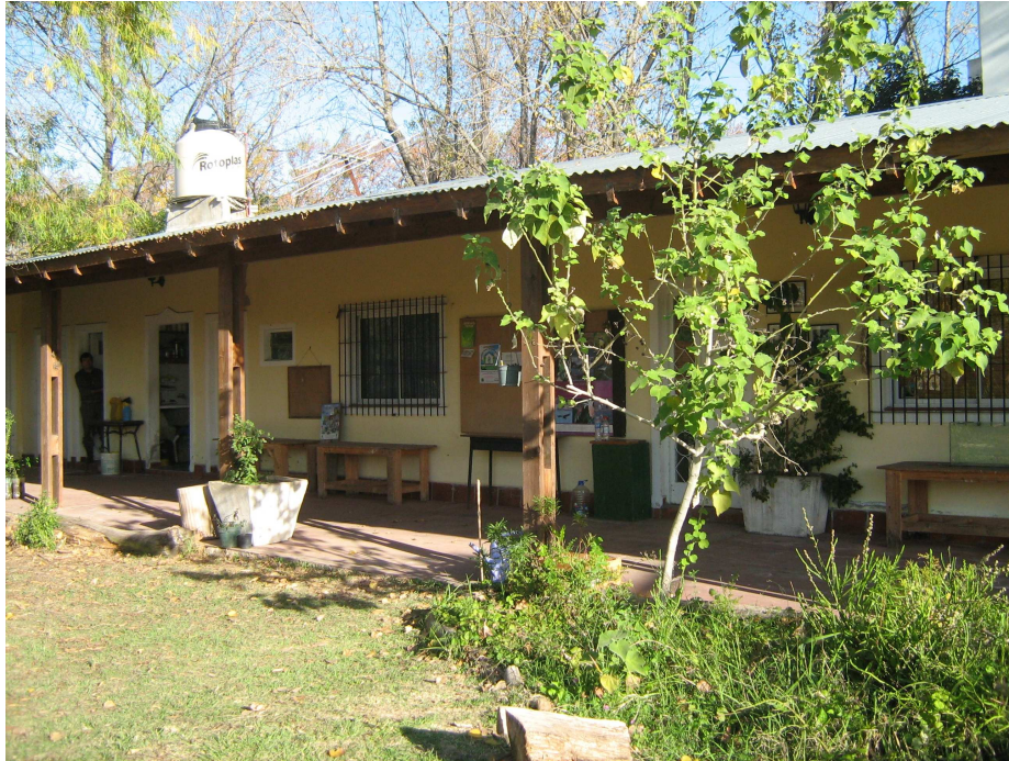
Foto 30. Galería con acceso a aula, baños, lavadero, duchas y oficina. Foto: Bárbara Gasparri.
